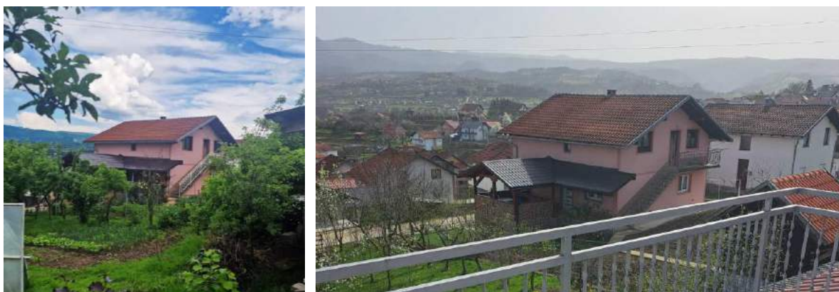
Стамбени објект источно од предметне локације
